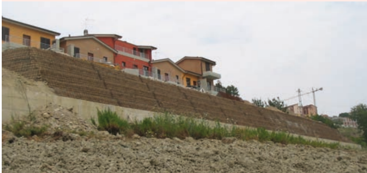
Posa in opera dei prodotti nella scarpata.
