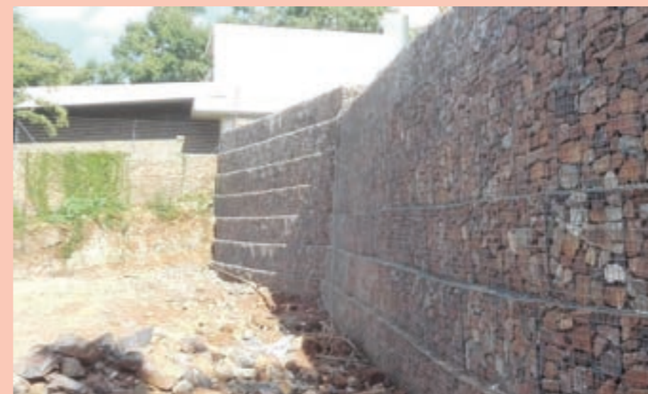
Lavori posa in opera
