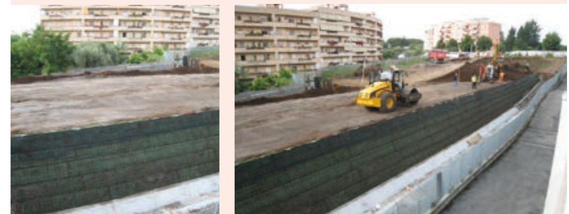
Viste della scarpata e opera in fase di rinverdimento.
