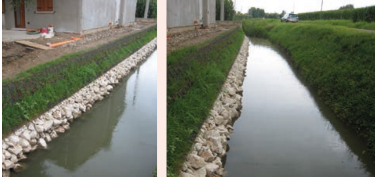
Viste della scarpata e opera in fase di rinverdimento.
