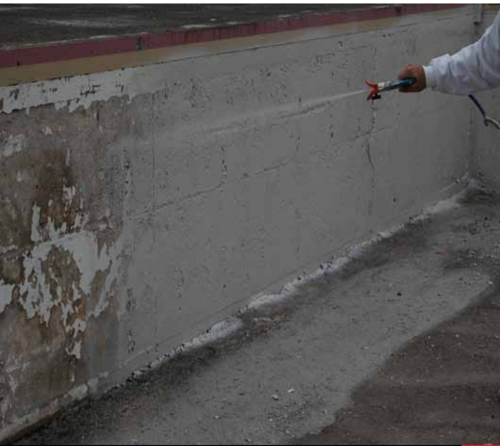
Applicazione airless del RX-513 sopra supporto in calcestruzzo
