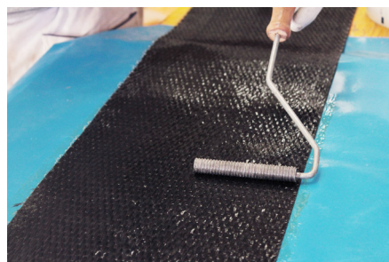
Fase 4: Omogeneizzazione dell'impregnante
