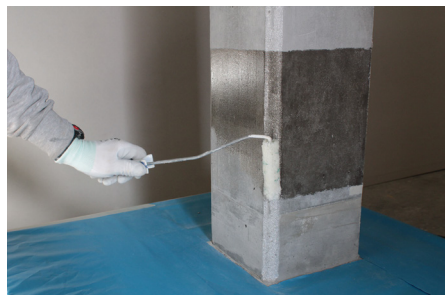
Fase 1: Trattamento con FASSA EPOXY 100, ove necessario
