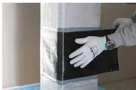
Fase 5: Posizionamento di FASSATEX CARBON UNI 300 / 600
