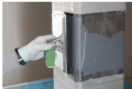
Fase 2: Regolarizzazione con FASSA EPOXY 400
