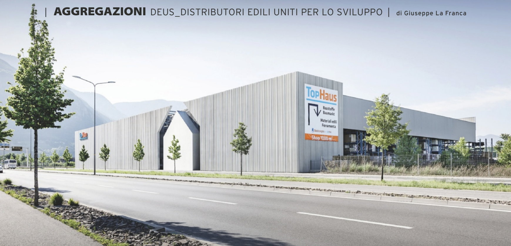
La rinnovata sede TopHaus, leader altoatesino della distribuzione edile, situata alla periferia sud di Bolzano
